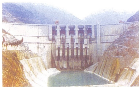
水电站大坝采用网纤维混凝土可起到良好的抗冲击、防渗作用。
