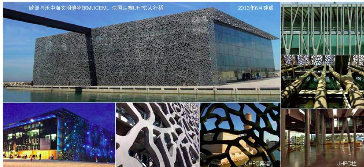
承重结构和维护幕墙
