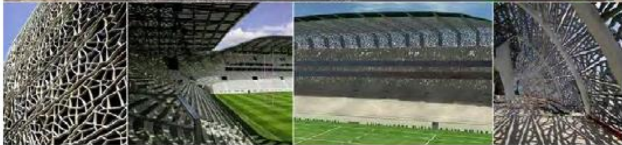
建筑维护和屋面结构
