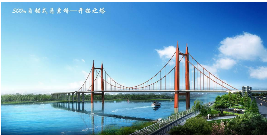
株洲市枫溪大桥—主跨300 m的双塔单跨自锚式悬索桥
