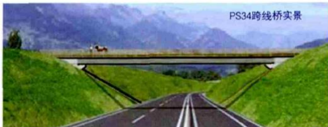
法国A51公路PS34桥
